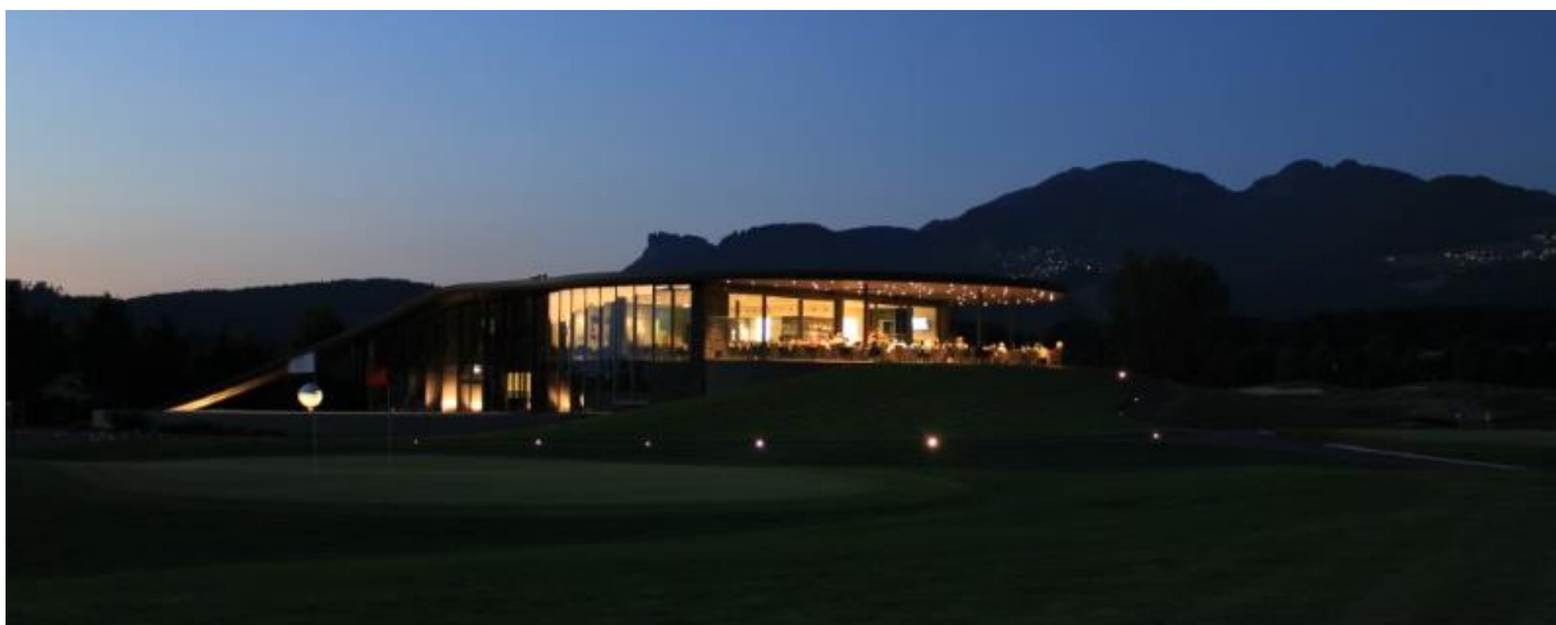
In der Nacht wird das Clubhaus von stimmungsvollen LED Lämpchen beleuchtet. Die Gebäude Silhouette verschmilzt gleichsam mit den Lichtern der umgebenden Bergdörfern Fraxern, Viktorsberg und Übersaxen im Hintergrund
